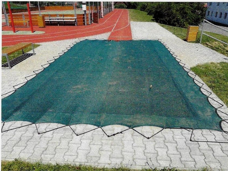
Vyobrazen příklad uchycení do bet.dlažby – u doskočišť bez lapačů písku
